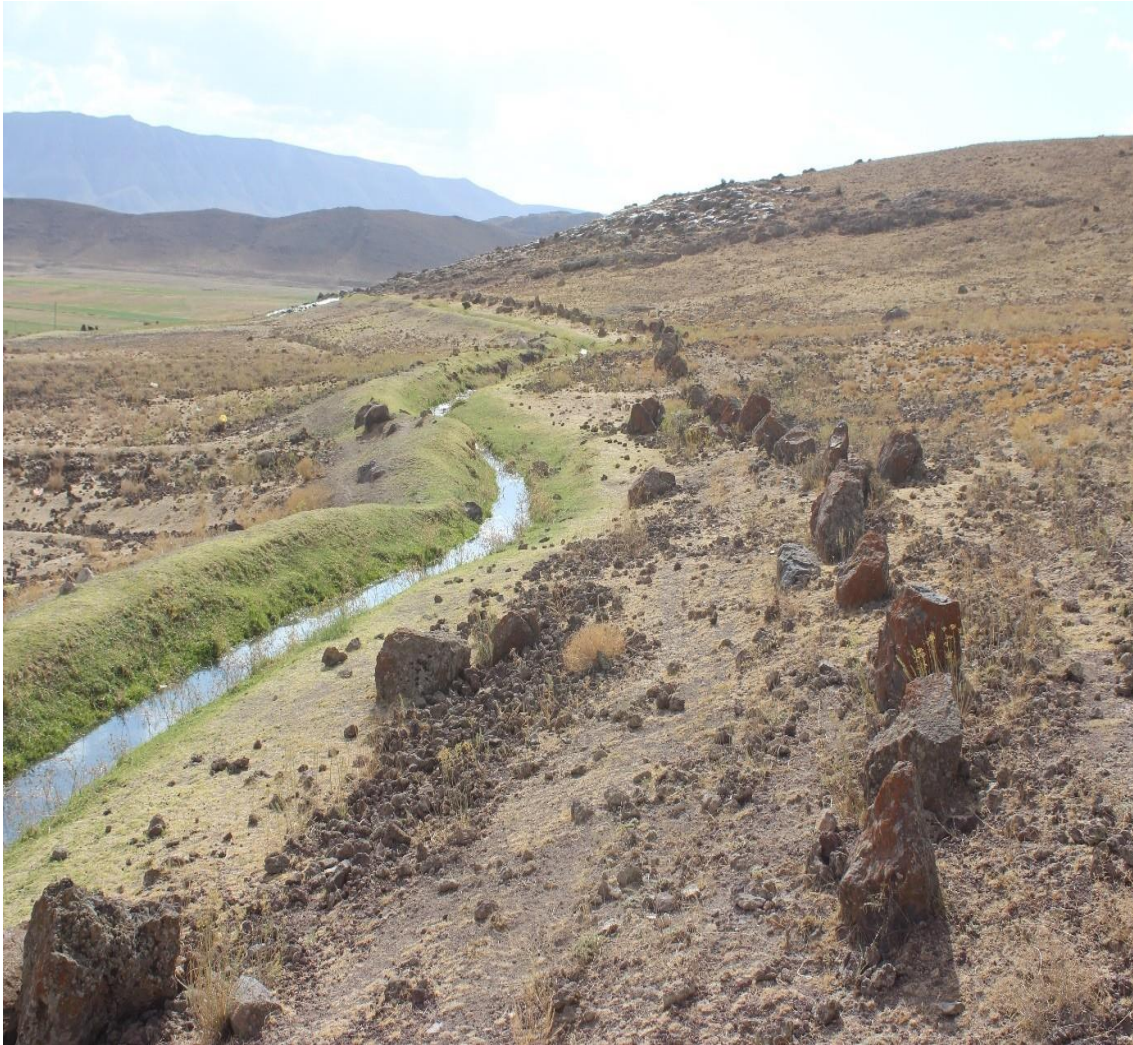
Şekil 2: Su kanalı ve istinat duvarı
