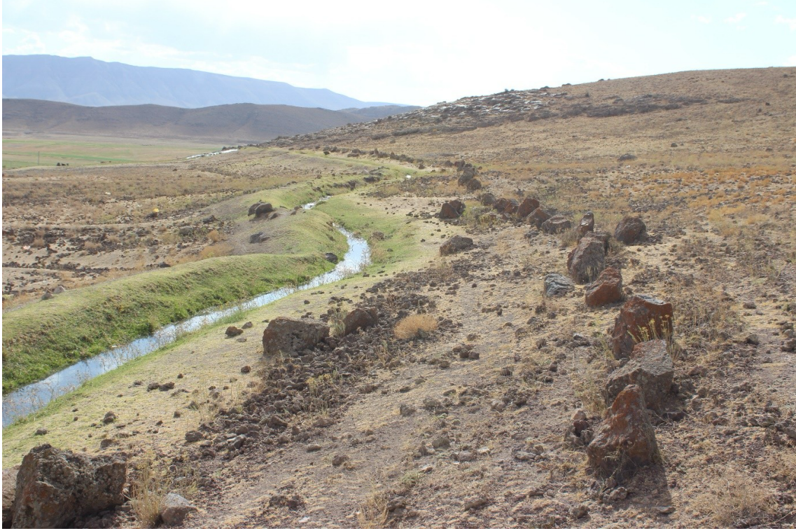
Şekil 2: Su kanalı ve istinat duvarı
